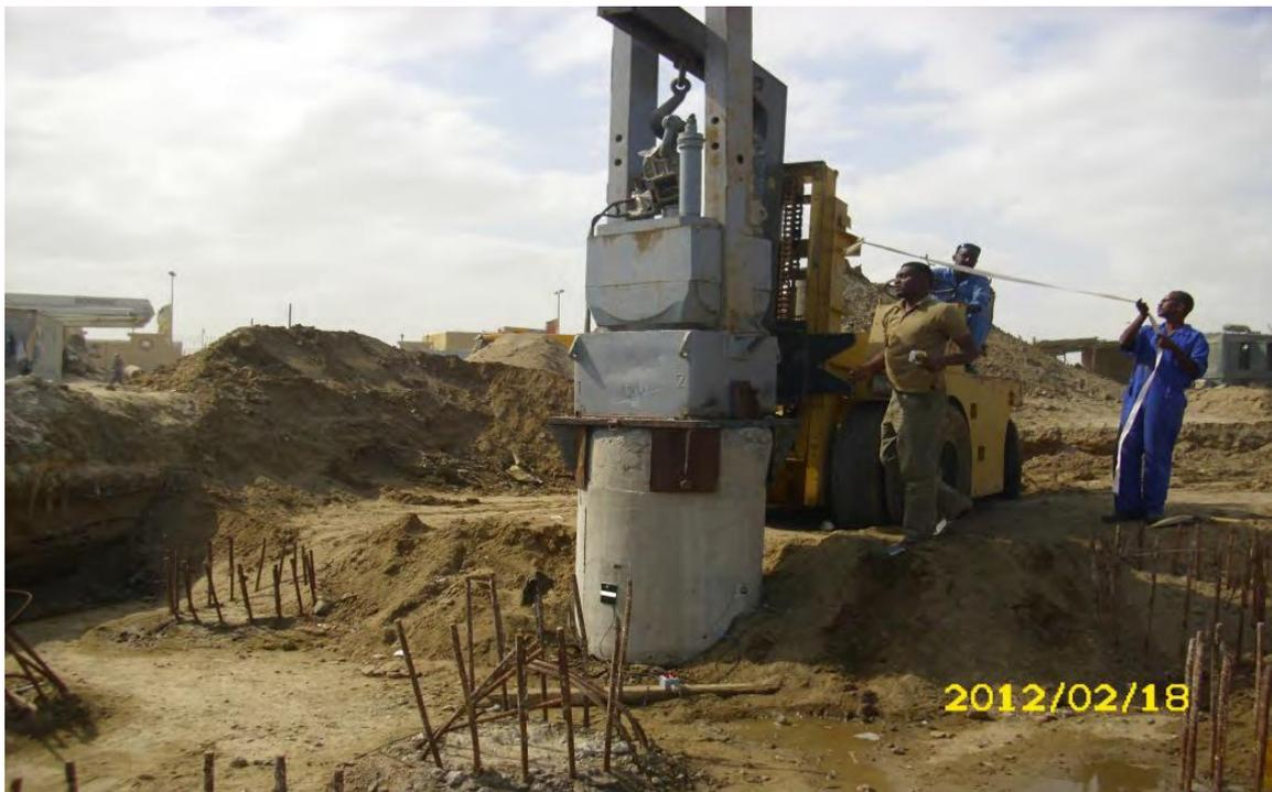
**Figure 40. 3:** SIMBAT Dynamic Pile Load Test
